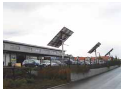
Ces panneaux solaires montés sur une structure peuvent être examinés par l'arrière pour minimiser les reflets.
