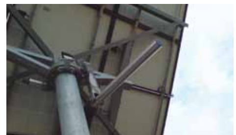
Mais l'inspection par l'arrière n'indique aucun point chaud. Les points chauds sur l'autre face sont causés par la réflexion.
