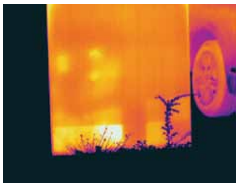
Ces points chauds semblent indiquer des cellules photovoltaïques inefficaces. Mais une inspection plus précise montre que plusieurs d'entre eux sont le reflet de la chaleur des personnes debout devant le panneau.
