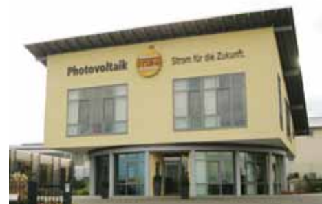
Toutes les 10 minutes, l'étage supérieur du bâtiment de Solartechnik Stiens, à Kaufungen, tourne presque imperceptiblement pour que les panneaux solaires du toit restent orientés vers le soleil.
